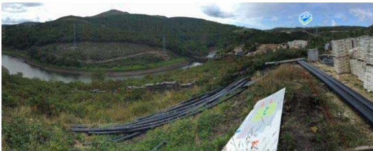
Imagen de obras en la central de Novo Castrelo cedida por Adegas. / FINS EIREXAS
